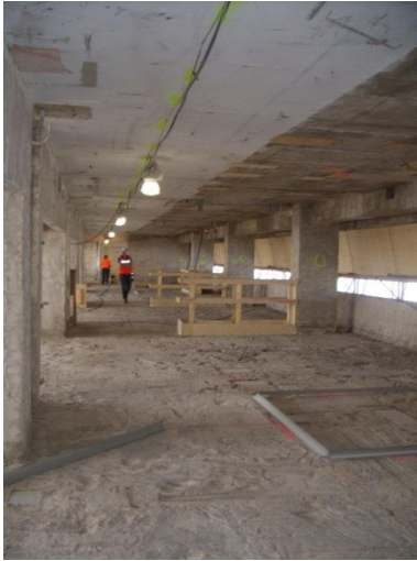
Kuva 5 Meilahden potilastorni pu- rettiin paljaalle betonipinnalle. Yllätyksiä ei pitäisi tämän jälkeen tulla.
