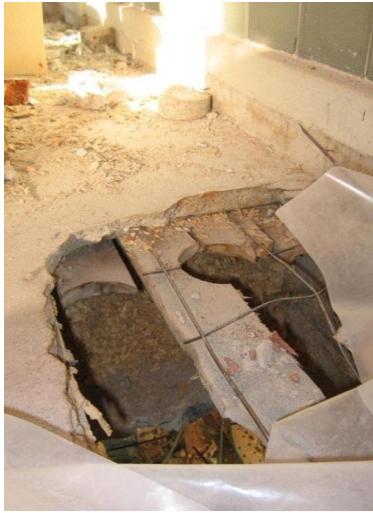
Kuva 3 Kohteessa piti tehdä pinta- korjauksia, korjaustyö kuitenkin laajeni löydettyjen vaurioiden vuoksi. Yllätykset olisi voitu välttää laajemmilla tutkimuksilla
