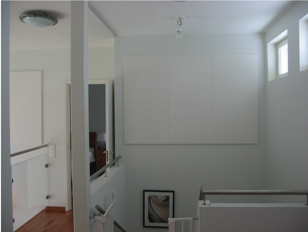
Kuva 7.3 Kohteessa 2 asennettuja akustiikkalevyjä. Etualalla portaikon 2,16 m 2 :n asennus.
