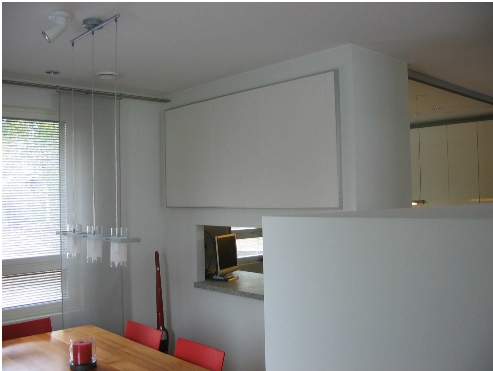
Kuva 7.2 Kohteessa 1 ruokailuhuoneen seinään kiinnitetty n. 2,4 m 2 akustiikkalevyä.
