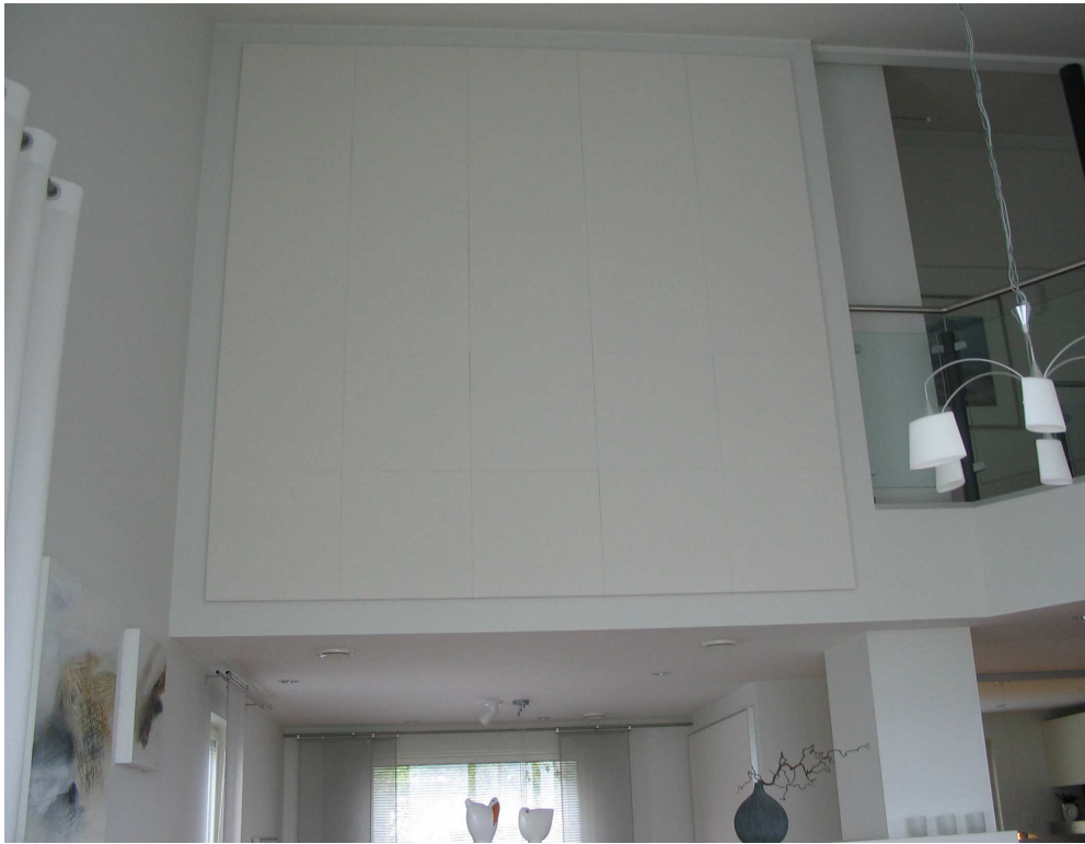
Kuva 7.1 Kohteessa 1 seinään liimattu 9 m 2 akustiikkalevyjä.
