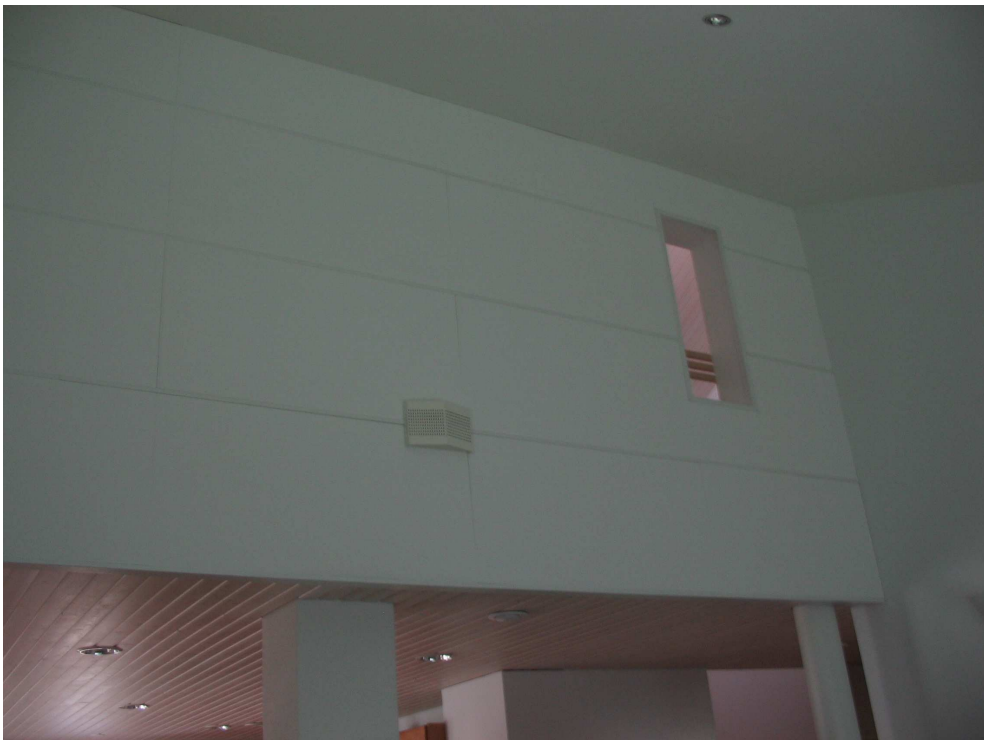
Kuva 7.6 Kohteessa 3 olohuoneen seinään aiemmin asennettuja akustiikkalevyjä.
