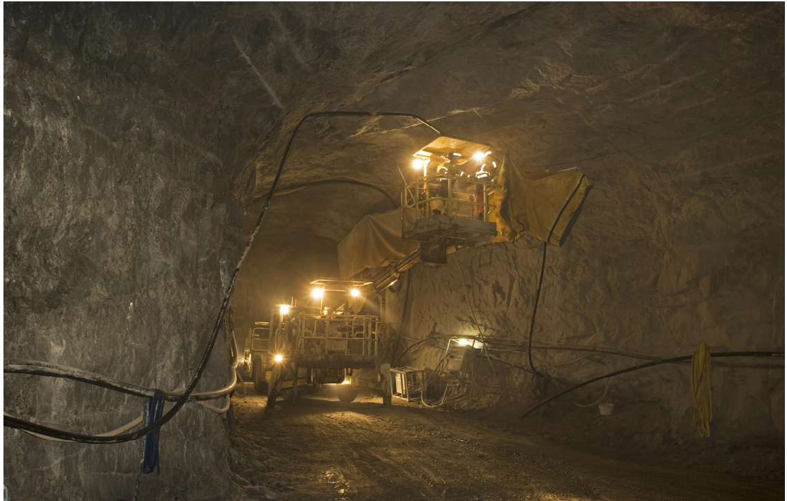
Kuva 4 Kehäradan ajotunnelin louhintaa syyskuussa 2009, kuvaaja Matti Kolho
