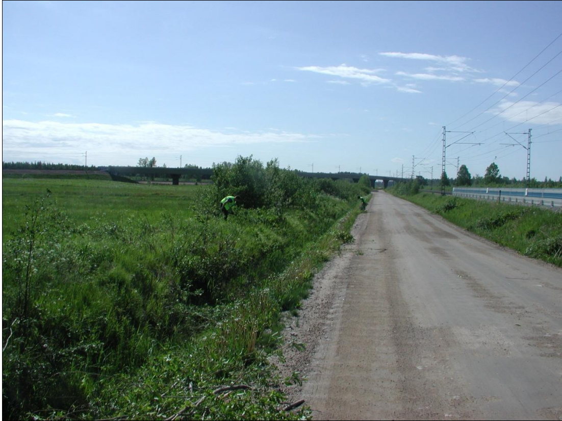
Kuva 1. Näkymä mittauspaikalta etelään. Kuvassa raivataan pensaikkoa tien ja pellon väliseltä pientareelta. (kuva: Jarkko Valtonen)
