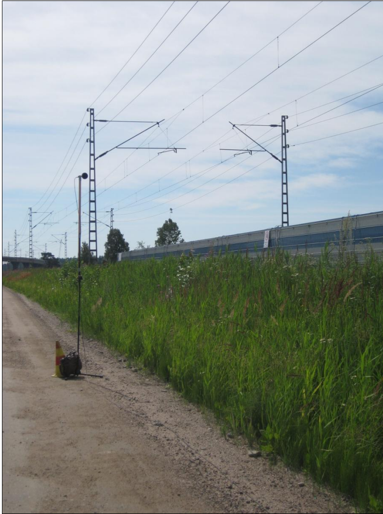
Kuva 4. Mikrofonin lähemmässä tarkastelupisteessä meluesteen takana (7,5 metrin etäisyydellä raiteen keskilinjasta ja 1,2 metriä kiskon selän korkeuden yläpuolella).
