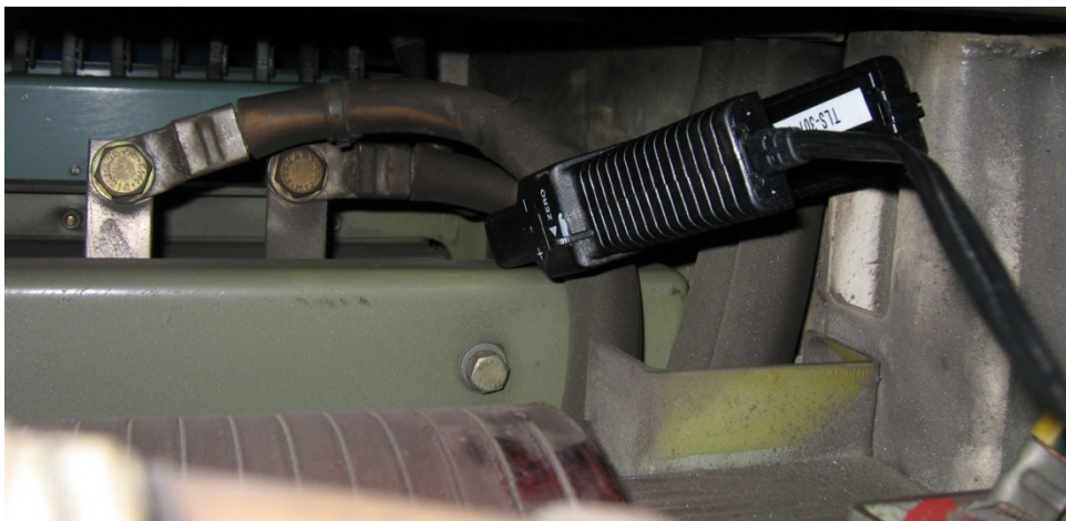
Kuva 4.2 Virtapihti paikallaan jarruvastuskaapelin ympärillä.
