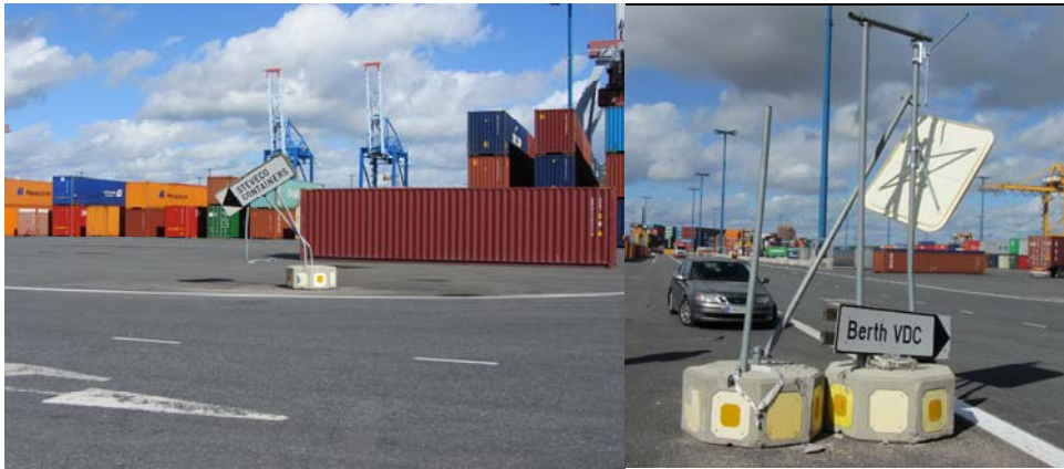
Kuvat 37 ja 38. Vaurioituneita merkkejä Vuosaaren sataman suljetulla satama-alueella.
