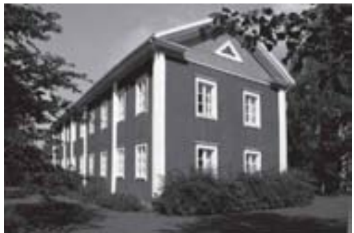
Kuva 15. Matti Antilan kaksikerroksinen talonpoikaistalo, ns. Vanha Antila, jonka joenpuoleinen sivu ja pääty toistavat klassismin tyylipiirteitä.
