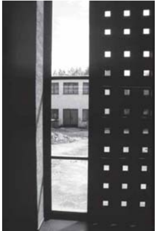
Kuva 118. Hiljainen kurkistus kirjaston takapihalle lasisesta itävarauloskäynnistä. Hyljätyin tehtaan hen- ki on haluttu saada näkyviin ruostutetuissa, neliöin perforoiduissa ovilevyissä.
