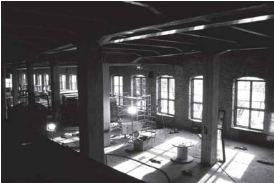
Kuva 39. Iltapäivän aurinkoa työmaalla, Ison Tehtaan tulevassa kirjastosalissa. Näkymä parvelta, kuten seuraavan aukeaman kuvassa valmiista kirjastosta.
