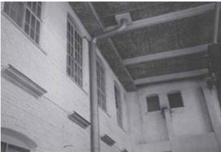
Kuva 93. Näkymä prässi-huoneesta ennen muutosrakentamista. Prässit oli tuotu paikalle 1962, ja seinät ja katto rakennettu siten niiden ympärille. Vanhat ulkoseinät oli kalkittu valkoisiksi. Tämä näkymä toi mieleeni ensi käynnillä keskiaikaisen linnan sisäpihan.
