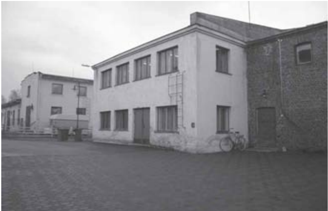
Kuva 20. Edessä entinen lyijylankaosasto (n:o 8), joka vielä odottaa persukorjaamista ja jossa on kansalaisopiston kudontatiloja. Takana vasemmalla entinen pintakäsittelylaitos (n:o 7), joka kesällä 2005 oli taidemuseon työmaana.
