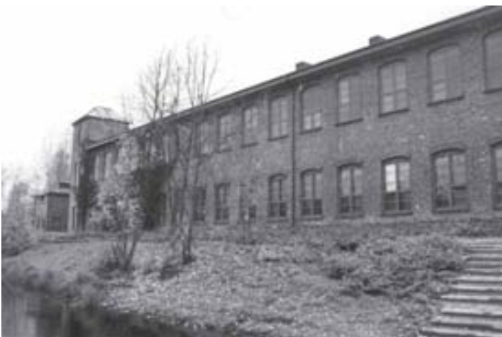
Kuva 12. Iso Tehdas joenpuolelta 2005. Rannassa ollut pumppaamo saatiin lopulta pois ja kävelypolku kulkee kirjaston ikkunoiden ohii. Uloskäyntiä suoraan rantaan ei kirjastosta voitu rakentaa valvontasyistä, tosin ei komeaa kaksikerroksista 18 ikkunan yhtenäistä rivistöäkään olisi kannattanut rikkoo. Edessä oikealla portaat rantalaiturille.
