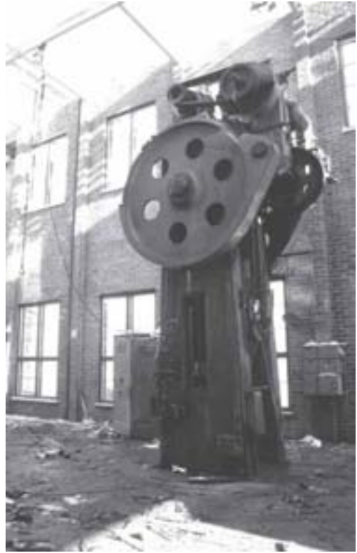
Kuva 34. Iso prässi ilman kattoa korjaustöiden aikaan keväällä 1997. Onneksi katto oli huono ja vuotava, niin että tilalle tarvittiin uusi ja parempi - ja saatiin lasikatteinen katukahvila!
