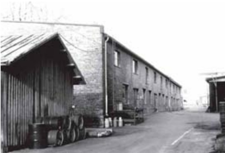
Kuva 80. Paukun Keskusvarasto (rakennus n:o 4, nykyisin Makasiini) ja puinen varastorakennus pari vuosikymmentä sitten, edessä öljyym. tynnyreitä.
