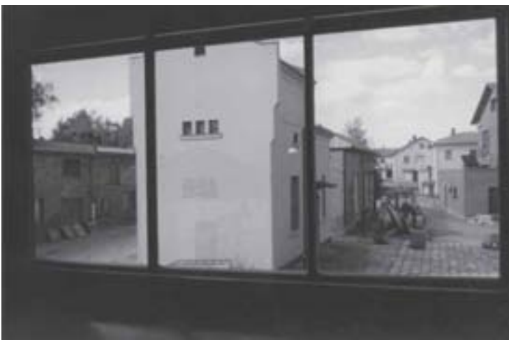
Kuva 72. Kurkistus Ison Tehtaan naulakkotiloista tiiviseen “kaupunkiin” Paukun aukiolle, jonka laatoitustyömaa käynnissä.
