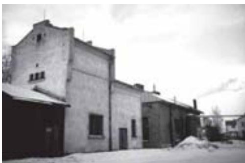
Kuva 9. Paja (alk. kaasulaitos, n:o 6), päädyssä puinen lisäosa, joka purettiin peruskorjauksessa.
