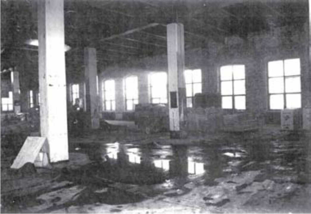
Kuva 31. Näkymä Ison Tehtaan alakerrasta, tulevasta kirjastosta ennen korjaustöiden aloittamista 1996.
