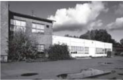
Kuva 17. 1930-luvulla rakennettu toinen iso tiilirakennus eli n:o 2 tai Työkalutehdas. Sen betonielementtirakenteinen laajennusosa on vuodelta 1970, ja siihen näyttää loppuvan perinteinen tiilinen teollisuusarkkitehtuuri Lapuan vanhan patruunatehtaan alueella. Tämä rakennus oli alueen ensimmäisen "purkaa vai korjata" -kiistan kohteena 1999.
