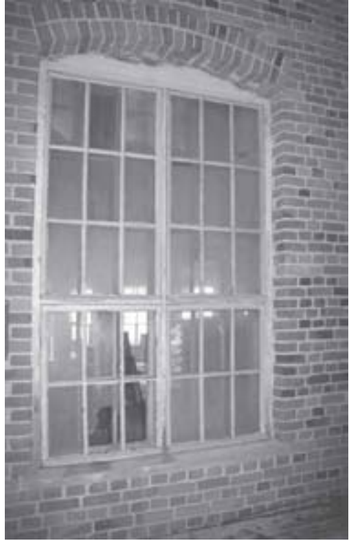
Kuva 24. Prässien tilassa oleva alkuperäinen, vuonna 1976 rikkoutumatta säilynyt ikkuna
