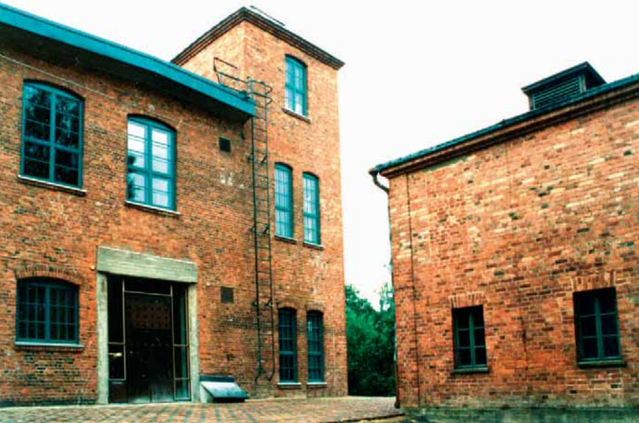
Kuva 68. Ison Tehtaan tornillinen länsipääty ja vanha muuntaja. Tiiliseinién välissä on voimakas materiaalin ja paikan tuntu.
