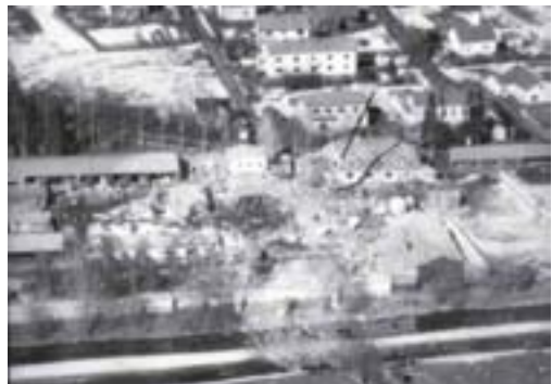
Kuva 155. Räjähdysten jälkeen lataamoa ei ollut enää. Myös Torstila vaurioitui. Tämä ilmakuva on Patruunatehtaan museon pystyvitriinissä.
