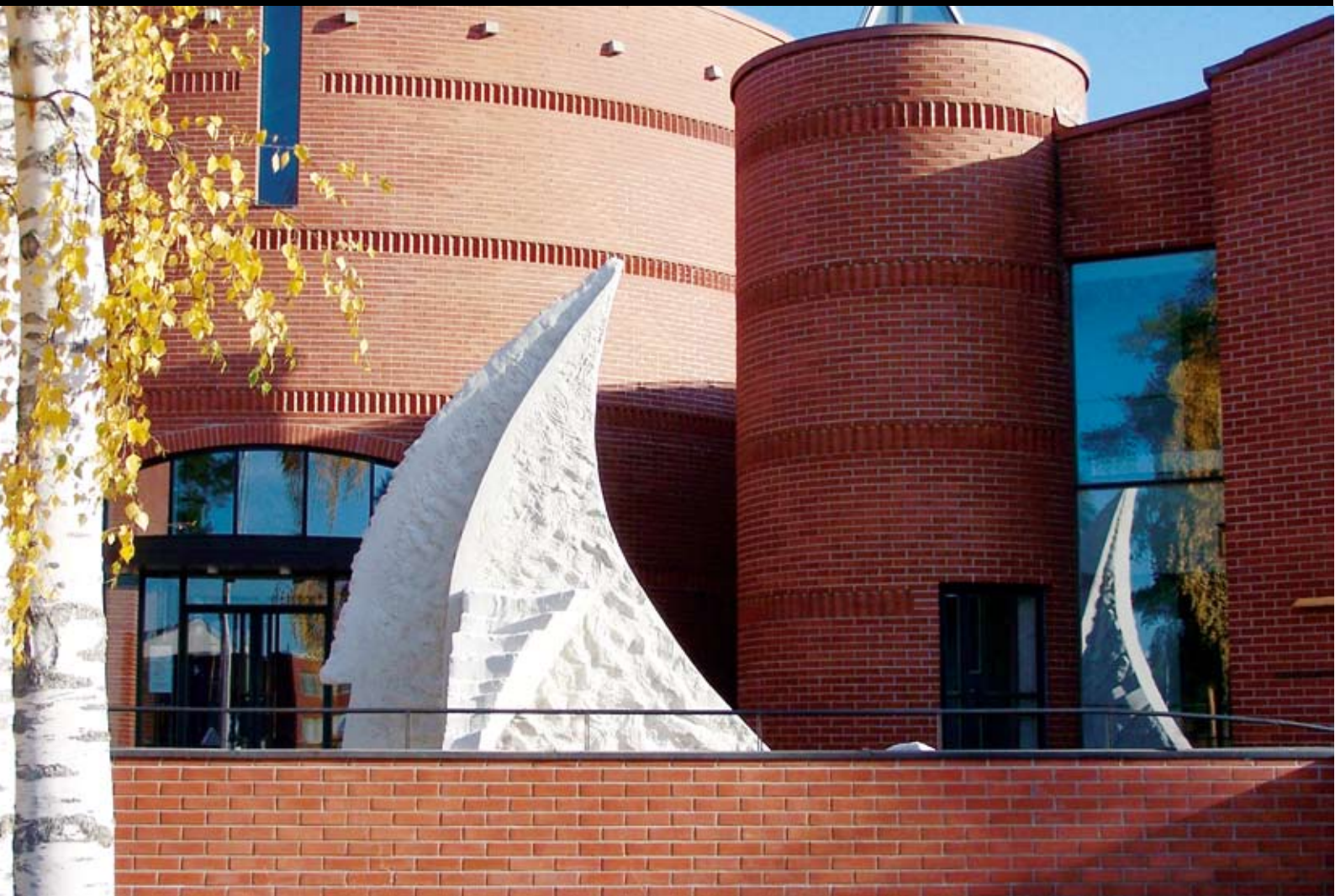
Kuva 113. Kari Tykkyläisen teos Ajatus Kankaanpään virastokeskuksen (suunnitellut Arkkitehtuuritoimisto Kouvo & Partanen) edessä. Tiiliarkkitehtuuri ja taide kaupunkikuvassa ovat Kankaanpälle ominaisia.
