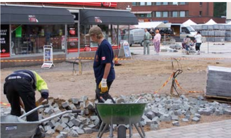
Kuva 89. Torikatu työn alla kesällä 2007.
