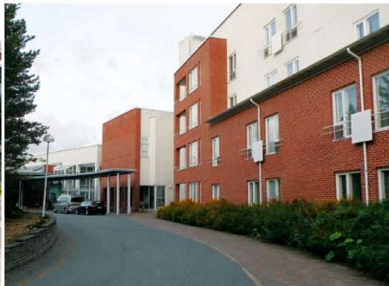
Kuva 115. Punatiiliarkkiteh- tuuri ja Kankaan- pään Kuntoutus- keskus kuuluvat kaupungin tunnet- tavuustekijöihin. Arkkitehtitoimisto Helamaa & Heiskanen Oy.
