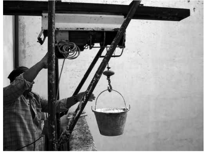
114. Sementti nousee ämpäreittäin pienellä työmaalla. Valokuva KH 2002.
