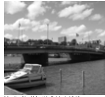
Martinsilta (Martti's Bridge), 1940.
