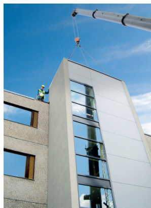
Kuva 9 Esimerkki hissimoduulin liittämisestä rakennuksen
