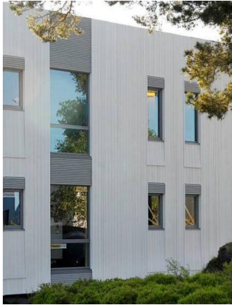
Kuva 7 TES-menetelmällä korjattu julkisivu Norjassa.
