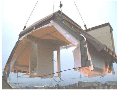
Kuva 13 Kattomoduulia asennetaan. [Saatavilla: http://www.emparen.ch/A50/Prefab_Retrofit_Animation.pps Viitattu: 7.7.2010].
