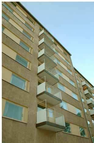
Kuva 14 Vanhaan rakennukseen asennettuja parveke-elementtejä
