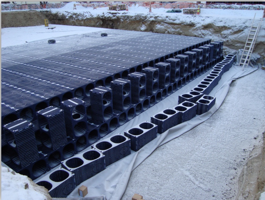
Kuva 32 Wavin Q-BIC-hulevesikasetteja asennusvaiheessa talvella 2010 (Kuva: Jarno Hujanen)
