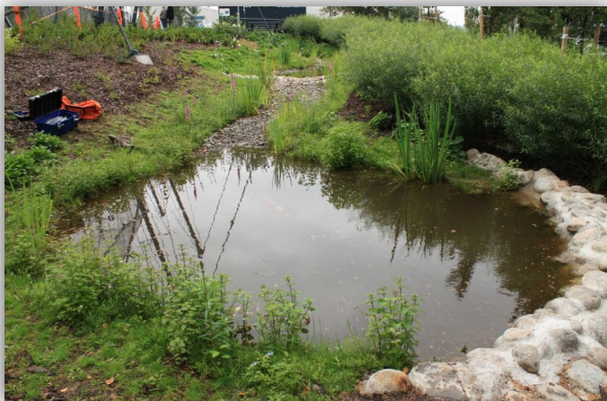
Kuva 33 Korkeasaaren kohteen viivytyksratkaisut ja eroosiosuojaus (Kuvat: Paula-Kaisa Leppänen)
