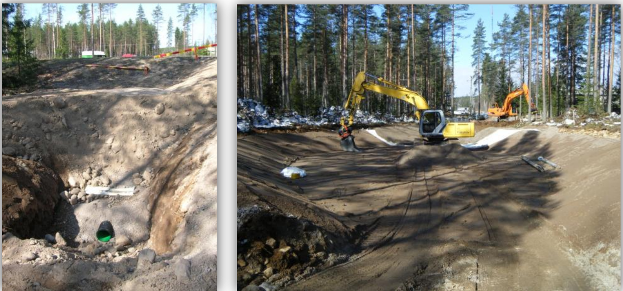
Kuva 24 Tien alitus ja altaan rakennus: bentoniittimaton päälle tasoitetaan suojakerrosta (Anniina Pouta)
