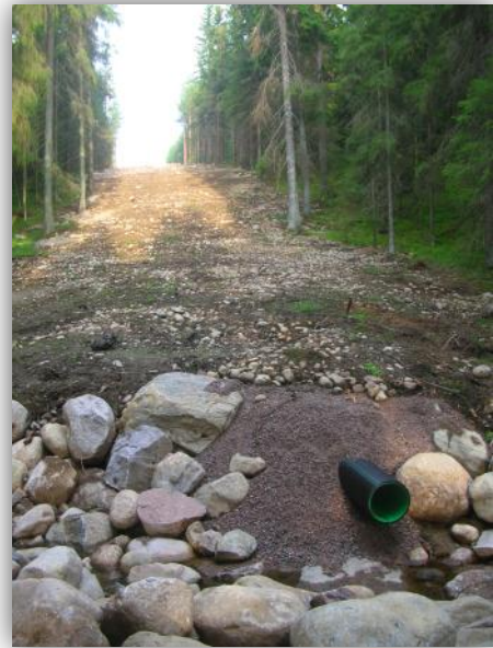
Kuva 25 Huleveden viivytyksallas teollisuusalueelta päin kuvattuna sekä eroosiosuojaus purkukohdassa (Anniina Pouta)
