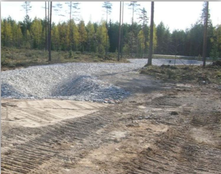
Kuva 25 Huleveden viivytyksallas teollisuusalueelta päin kuvattuna sekä eroosiosuojaus purkukohdassa (Anniina Pouta)
