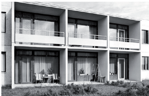
Kuva 36. Rakennusrungon ulkopuolelle sijoitetut parvekkeet ja niiden kantavat pieliseinät.
