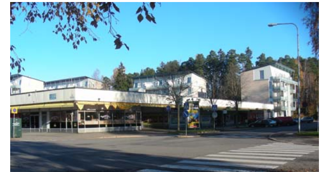
Puotilan ostoskeskuksen lähelle on rakennettu asuintaloja. Kuva otettu 27.10.2010.
