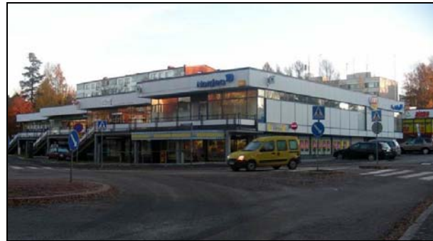
Kulosaaren ostoskeskuksen julkisivun rytmiä. Valokuvausaika on 27.10.2010.
