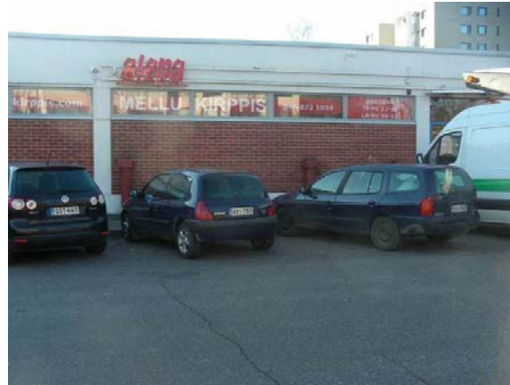
Betonirunko jakaa punatiilisen julkisivun samanmittaisiin osiin. Kuva 27.10.2010.
