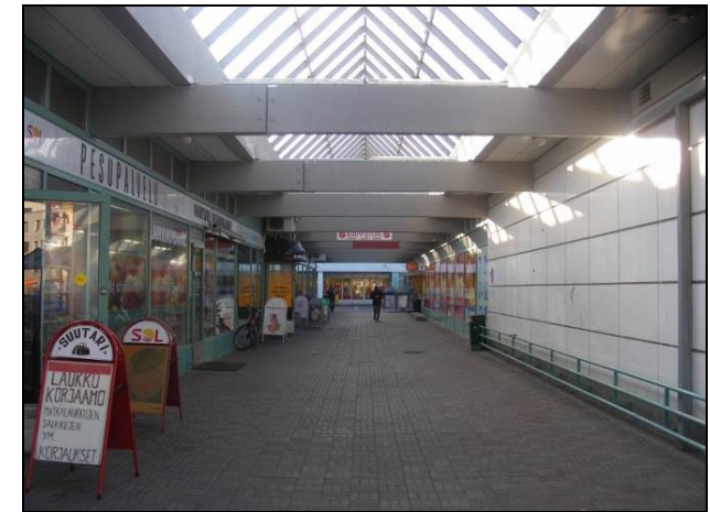
Kuva on otettu Laajasalon ostoskeskuksen käytävältä. Alun perin moduulimallisessa rakennusrykelmässä oli toisenlainen valokate. Kuva 27.10.2010.
