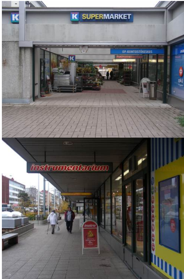
Yläkuva on ostoskäytävälle ja alhaalla olevassa kuvassa on näkymä Lauttasaarentien puoleiselta seinämältä käytävälle. 144
