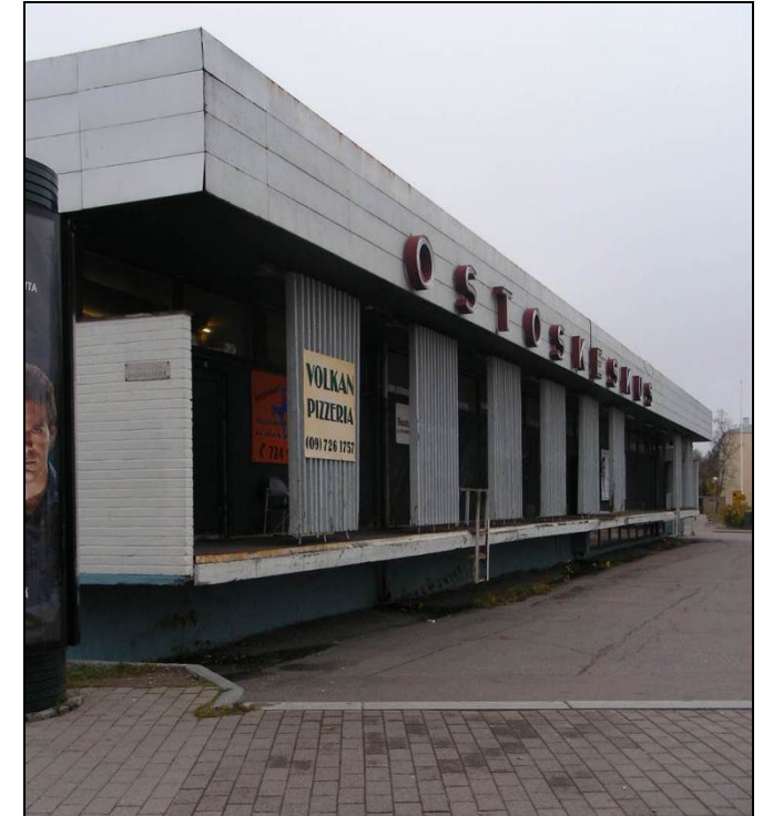
Suursuon ostoskeskuksen kaupunkikuvallisesti hallitsein julkisivu on huoltopuoli.
