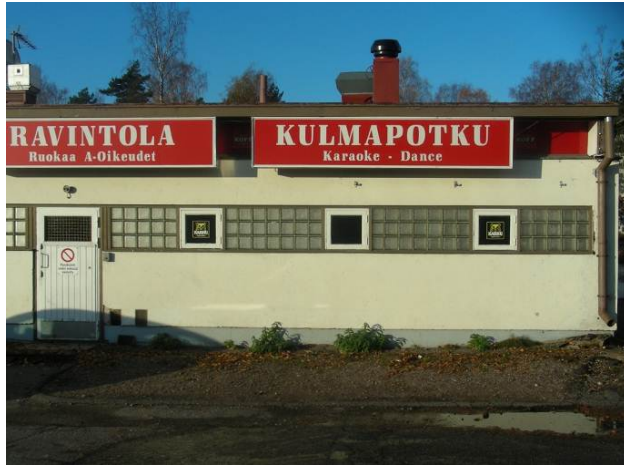
Ns. entisen apteekin talon Roihuvuorentielle näkyvä huoltojulkisivu viereiseltä pysäköintipaikalta kuvattuna 27.10.2010.
